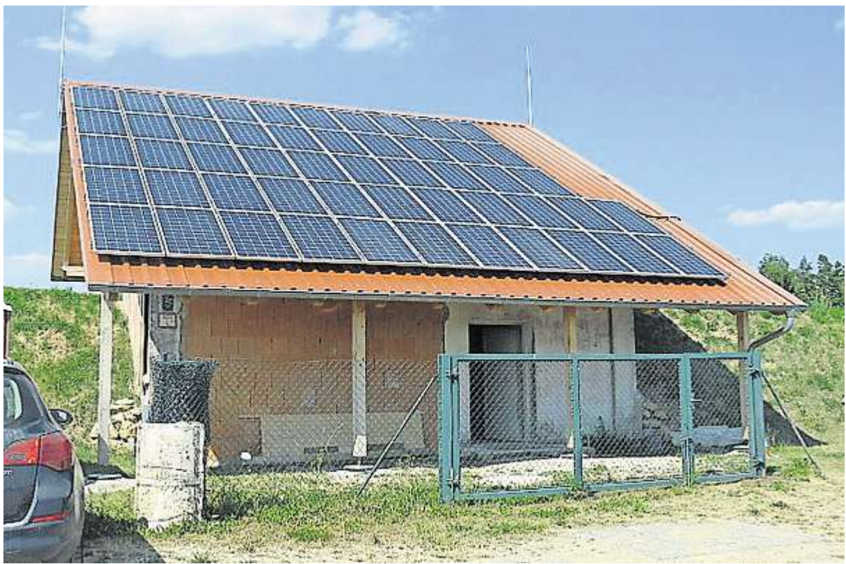
Der Zweckverband erneuert derzeit den Hochbehälter in Bergmatting.
